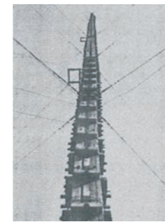
La prima torre di captazione dei fulmini sul Monte San Salvatore; si tratta della ex antenna della stazione radio della città di Berna, un traliccio di legno di 70 m di altezza.
