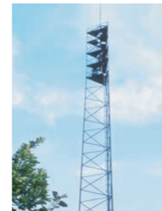
La seconda torre di captazione dei fulmini di 70 m fu innalzata sul Pian San Carlo nel 1950.
